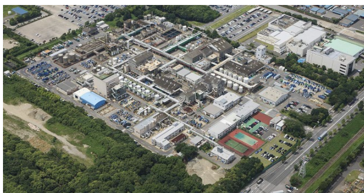
▲ 千葉工場全景
