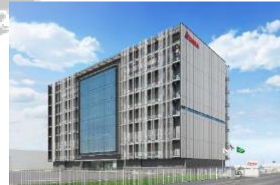
▲ 久喜研究所「新研究棟」建設
