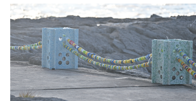
当社協力による、漂着プラスチックをアップサイクルした路肩ポール
