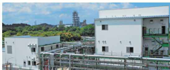
▲化粧品原料の製造設備 [千葉工場]
