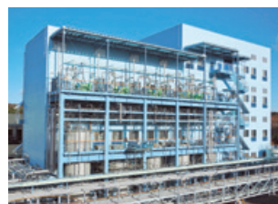
▲ポリオレフィン用高機能添加剤の製造設備 [三重工場]
