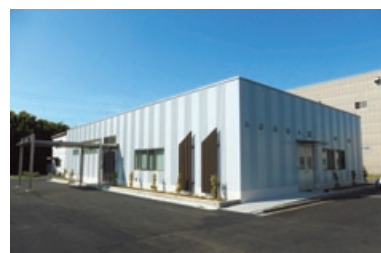
鹿島工場西製造所 メディカル材料用実験棟
