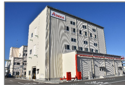
能力増強した相馬工場の潤滑油添加剤設備
