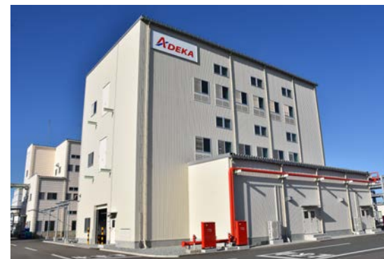
▲ 相馬工場 潤滑油添加剤設備
