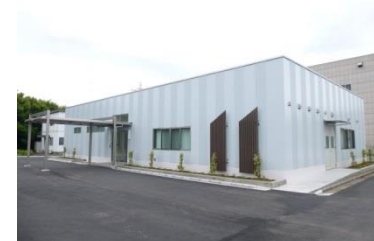
▲メディカル材料用実験棟
