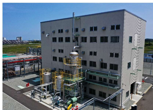
第二生産プラント排ガス処理設備
