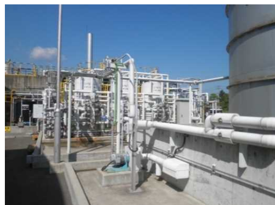
化学物質回収設備
