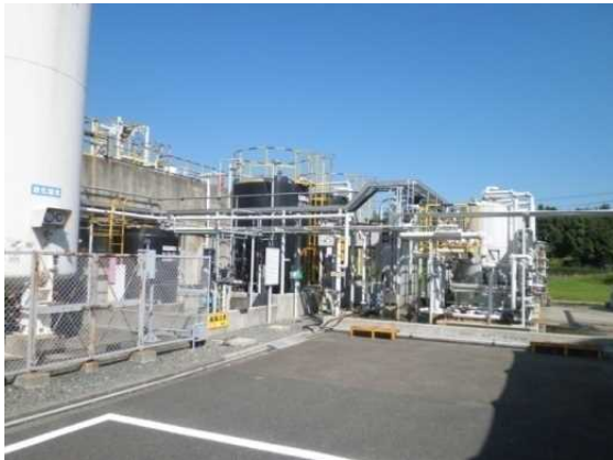
排水処理設備
