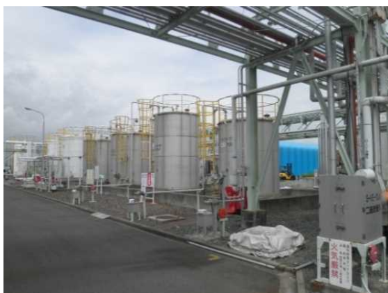
窒素シールされたタンク
