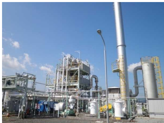
廃棄物焼却炉
