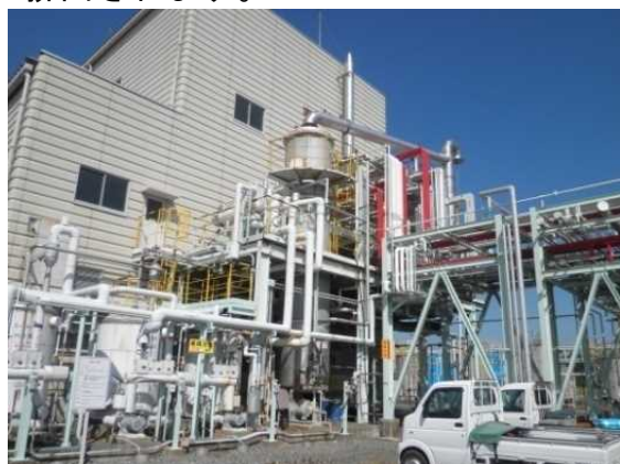
排ガス処理設備
