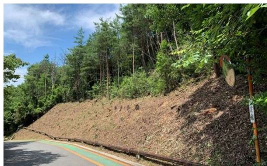
支障木伐採エリア
