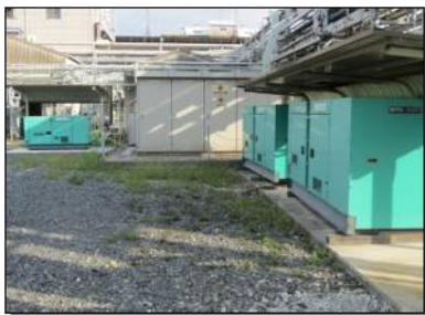
非常用ディーゼル発電機
