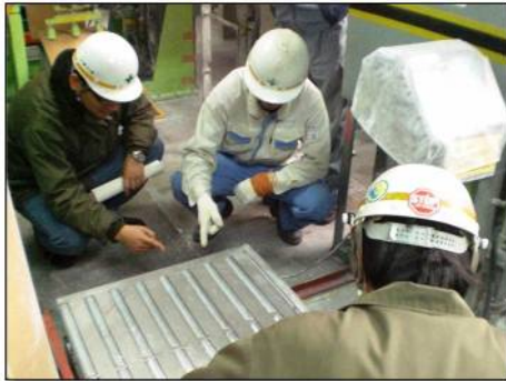
図-8 設備点検の様子
