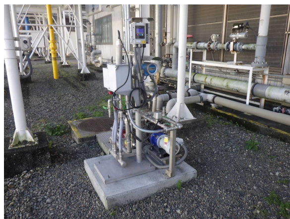
排水ラインに計測器増設
