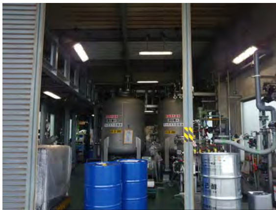
屋内照明に LED を使用する TEC 製品製造設備
