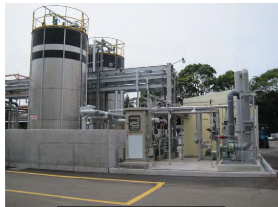
外灯に LED を使用する 過酢酸製造設備
