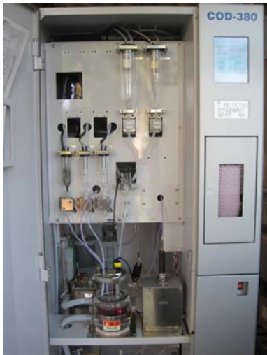
排水を監視する COD 計
