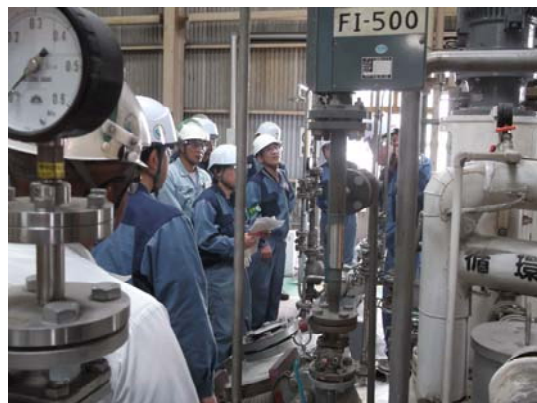
現地での安全点検の様子
