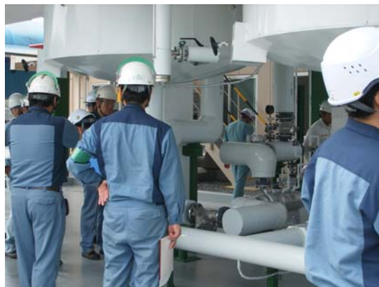
現地での安全点検の様子
