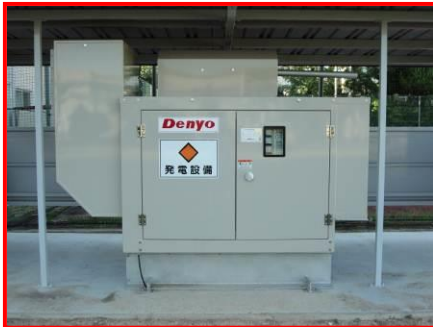
(非常用発電機導入)
