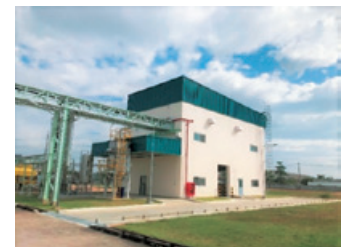
▲ 増強したタイの塩ビ用安定剤設備
