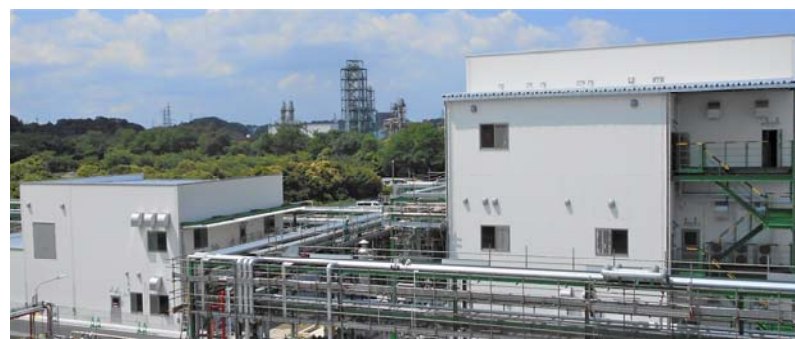
▲ 化粧品原料の製造設備 [千葉工場]
