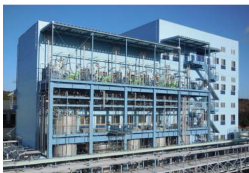
▲ ポリオレフィン用添加剤（光安定剤等）の製造設備 [三重工場]
