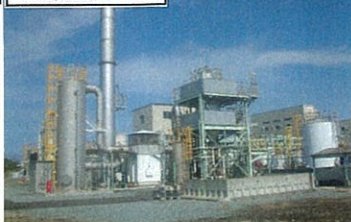
廃棄物焼却炉全景
