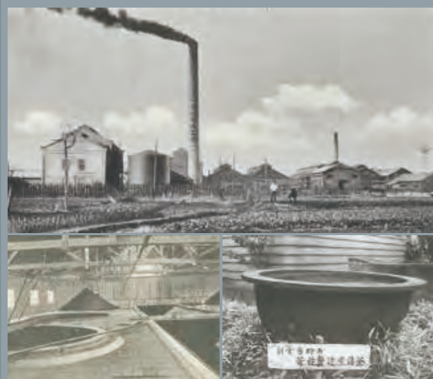
上:尾久工場全景 左下:か性ソーダ煮釜室 右下:創業当時のか性ソーダ煮詰釜
