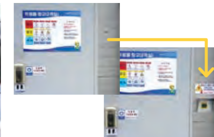
危険物倉庫前に静電気除去シートを設置し、引火事故リスクをなくす
