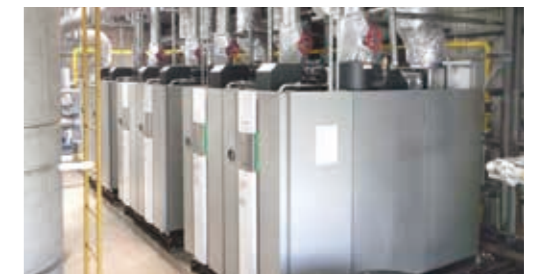
高効率省エネ型のガスボイラー設備(鹿島工場西製造所)
