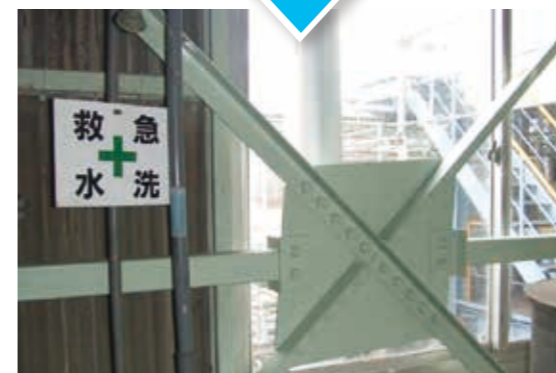
耐震補強(三重工場)
