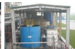
艾迪科精細化工(常熟)有限公司 除燐設備
