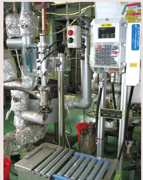
樹脂用添加剤充填機の更新(三重工場)
