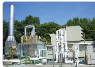
千葉工場のコージェネ設備
