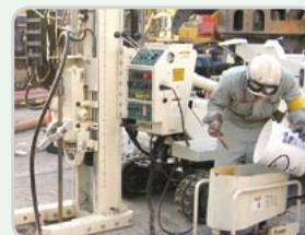
土壌地下水浄化事業: 微生物薬剤注入処理工事
