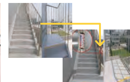
階段に滑り止めを貼付して転倒を防止、さらに中間柵を設置し二次災害を防ぐ
