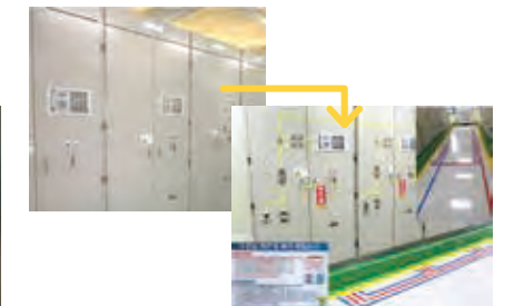
停電発生時、誰でもすぐに復旧できるように受電パネルに配線経路と手順を表示
