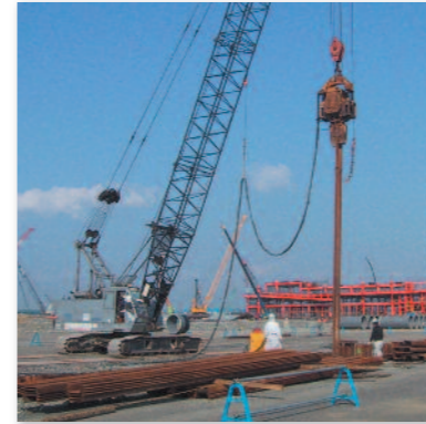
鋼矢板打設工事 アデカウルトラロック 鋼矢板用水膨張液状シール材 アデカウルトラシール 鋼矢板用水膨張ゴム丸棒
