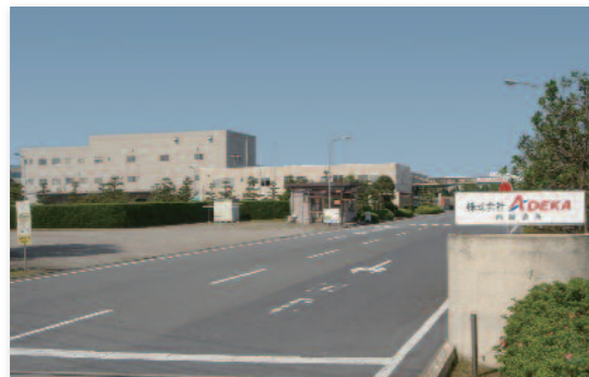
鹿島工場西製造所 (茨城県) 金属石けんなどの化学品及び、ホイップクリームなどの加工食品を 製造しています。 敷地面積：101,000m 2 製造品目：金属石けん、IT用材料
