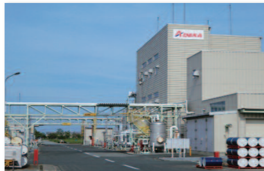
相馬工場 (福島県) 潤滑油添加剤を中心に製造しています。 敷地面積：228,458m 2 製造品目：潤滑油添加剤 「アデカサクラループの製造及び販売」で、BCMSの国際規格ISO22301を 取得しています。
