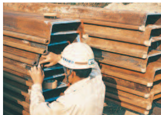
ゴムテープ貼付作業
