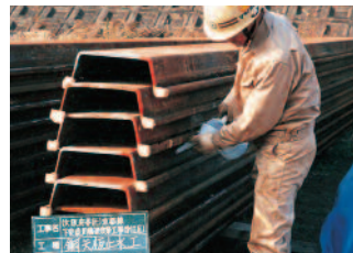
アデカウルトラロック流し込み作業
